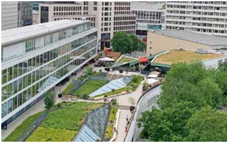
Der belebte Freiraum hinter dem Bikinihaus Berlin mit Blick in den Berliner Zoo, Architekten Hild und K Berlin FOTO: MARIA AUBÖCK
